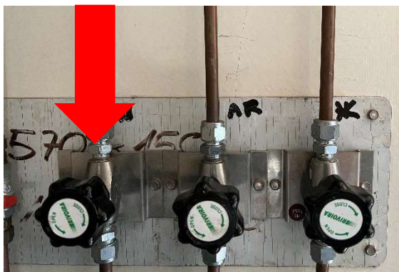
Figura 2. Manopola di N 2 da aprire lentamente prima dell'accensione dello strumento.
